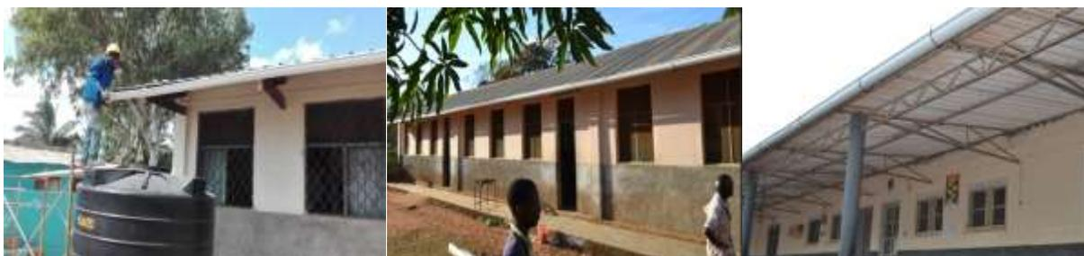
Figura 4. Montagem de sistema de aproveitamento de águas pluviais
